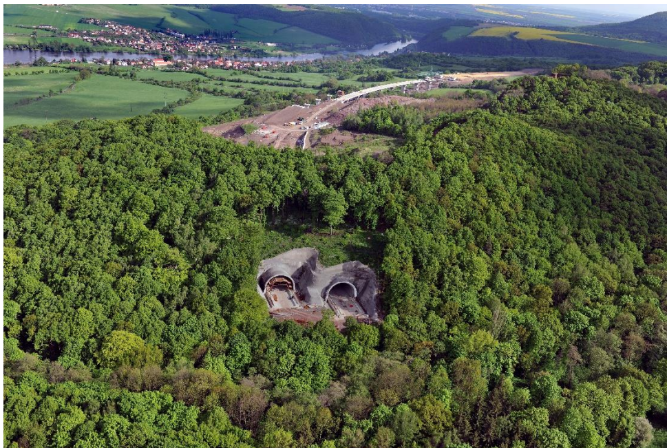
Dálnice D8 – ústecký portál tunelu Prackovice
